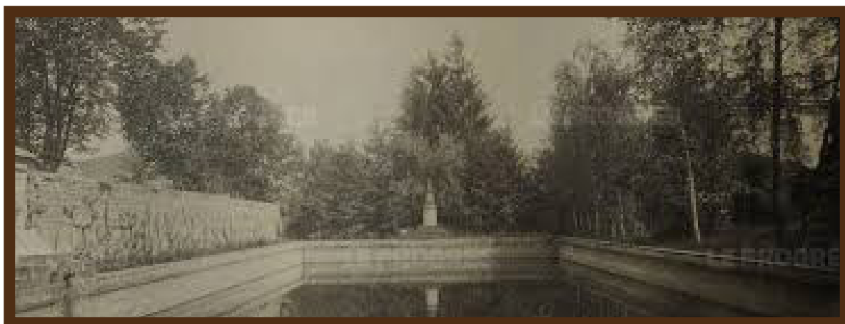
Le bassin avait été creusé par les jésuites pour remédier aux baignades des élèves dans le Doubs, jugées trop dangereuses
